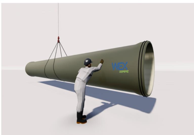
*Imagen 5: Levantando una tubería en un solo punto con un amarre para controlar el giro.*
